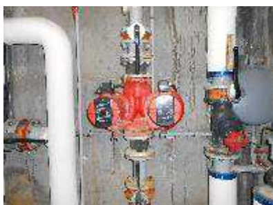
Photo des circulateurs
