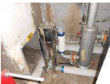
Photo du pot à boue magnétique
