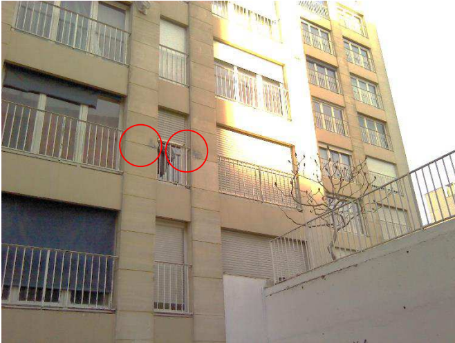
Défaut d'étanchéité des joints de pierre.
