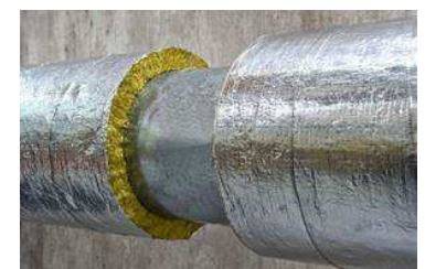
Calorifugeage laine minérale
