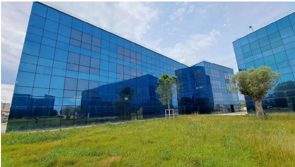
- FACADE DU BATIMENT B4 DONNANT DU COTE DU BATIMENT B3 :
